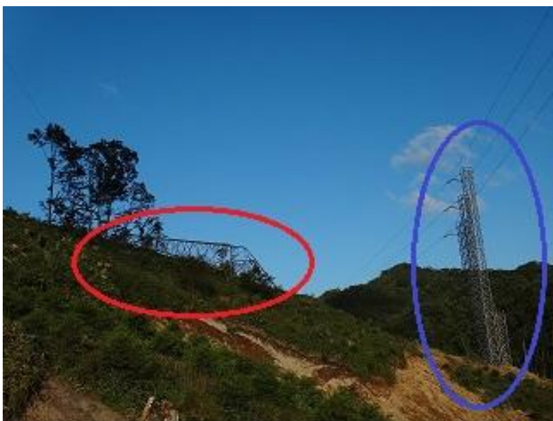
倒壊した送電鉄塔【左】と 鉄柱による仮復旧の状況【右】（むかわ町）
