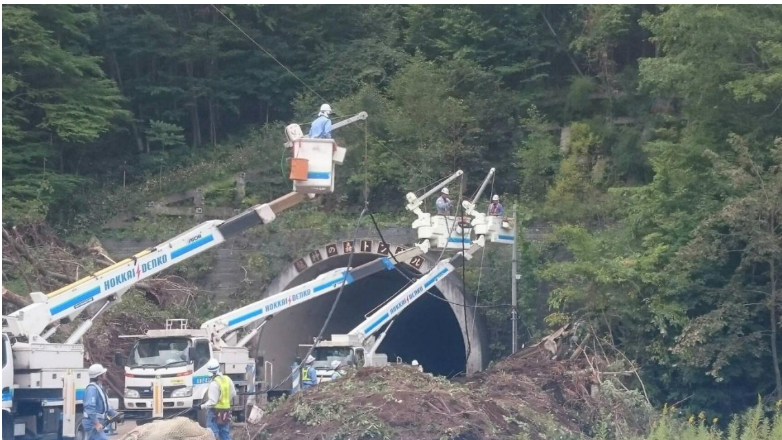
電線を張っている様子（厚真町）
