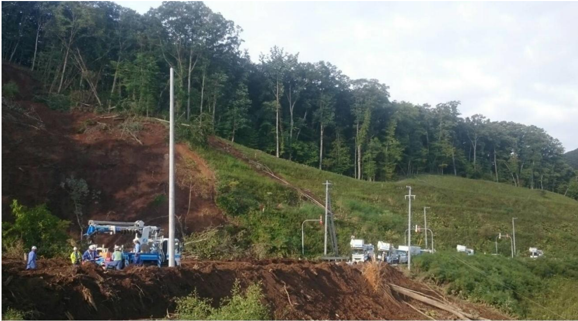
新たな電柱を建てている様子（厚真町）
